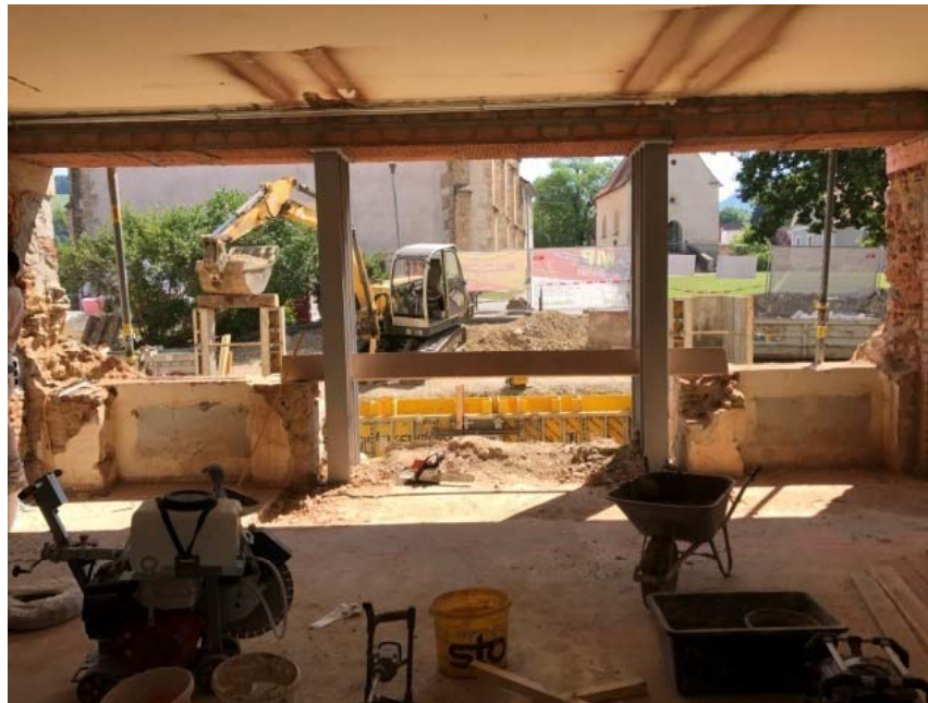
EINBRINGEN DER UNTERFANGUNG
