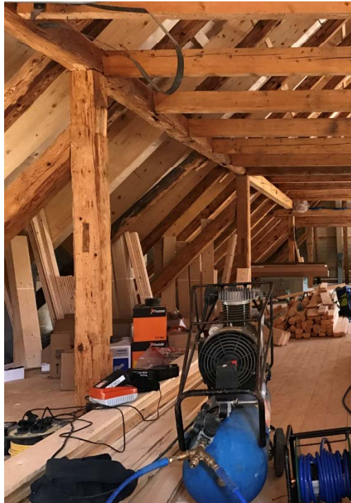
VERBLANKEN DES DACHSTUHLS
