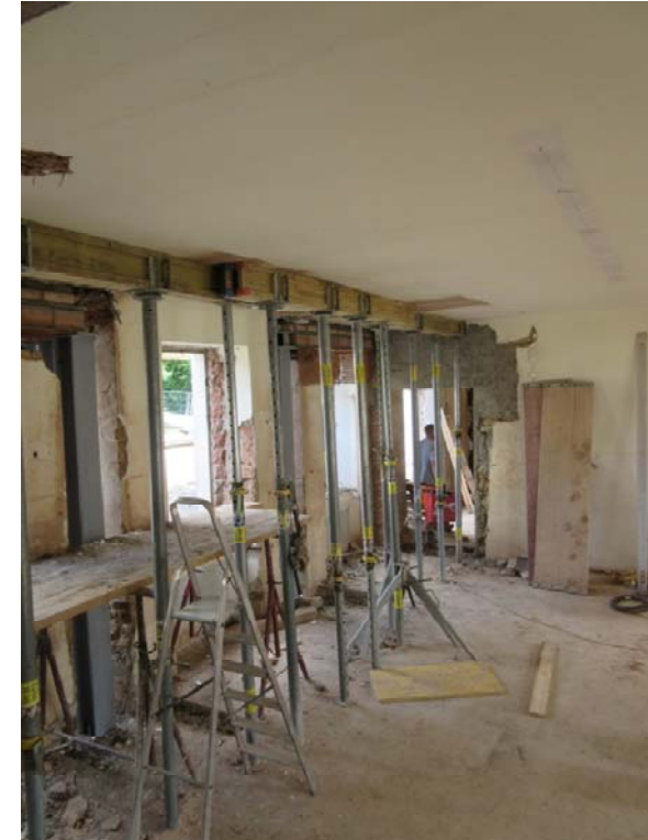
ÖFFNEN DER OSTFASSADE
