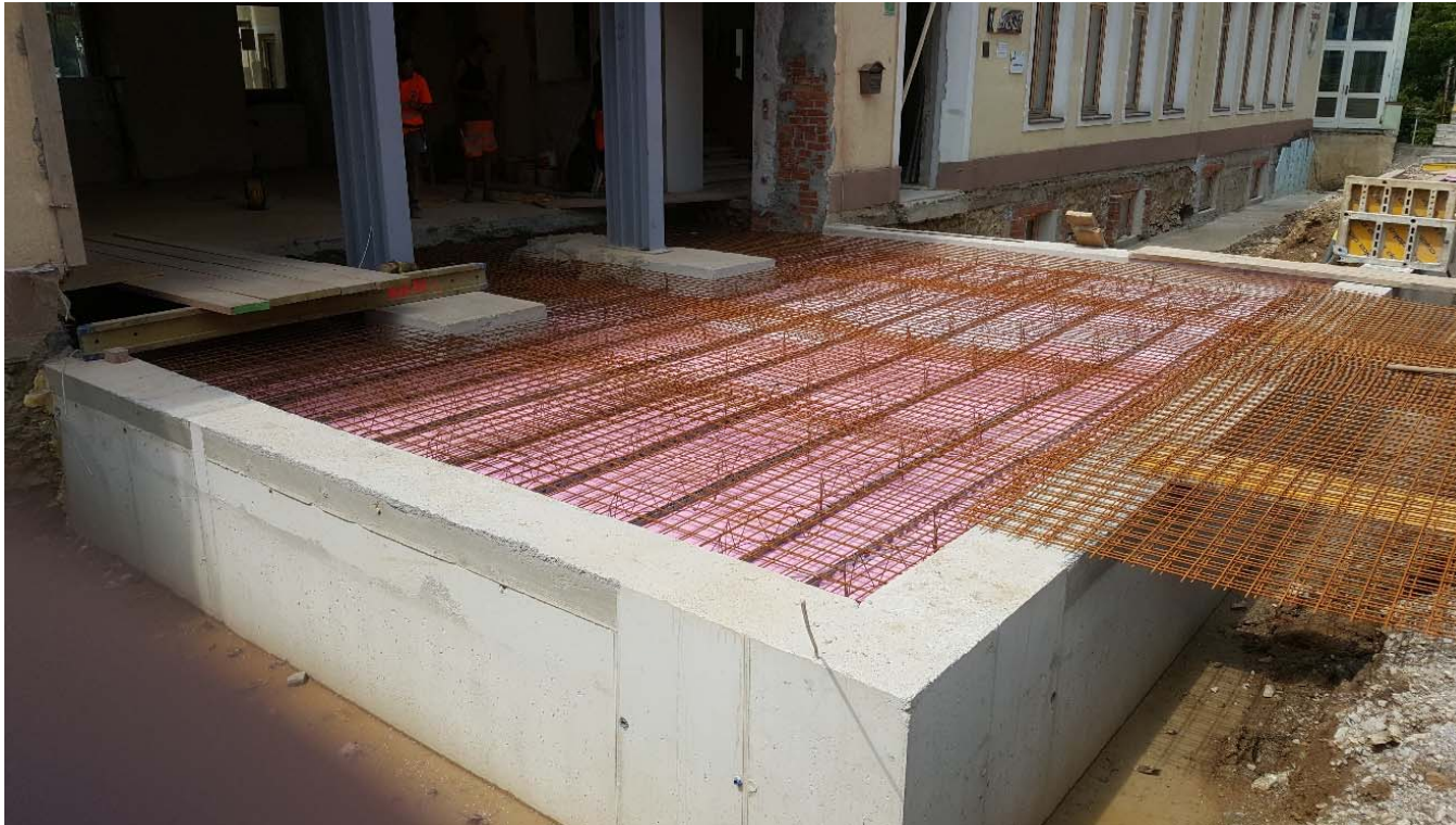
HERSTELLUNG DES FUNDAMENTS
