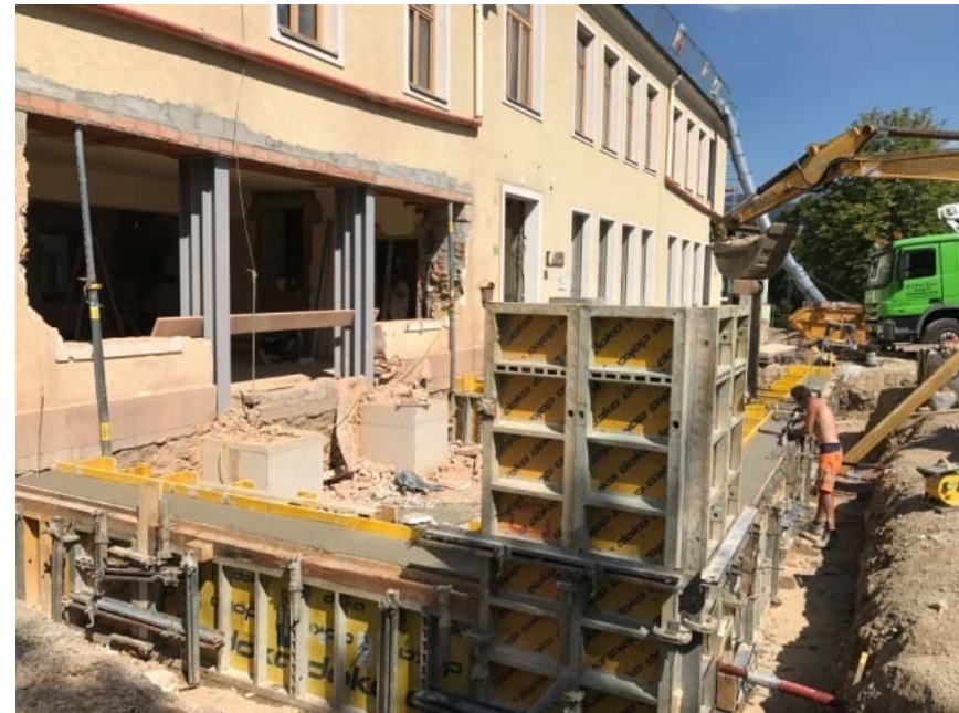
HERSTELLUNG DES FUNDAMENTS
