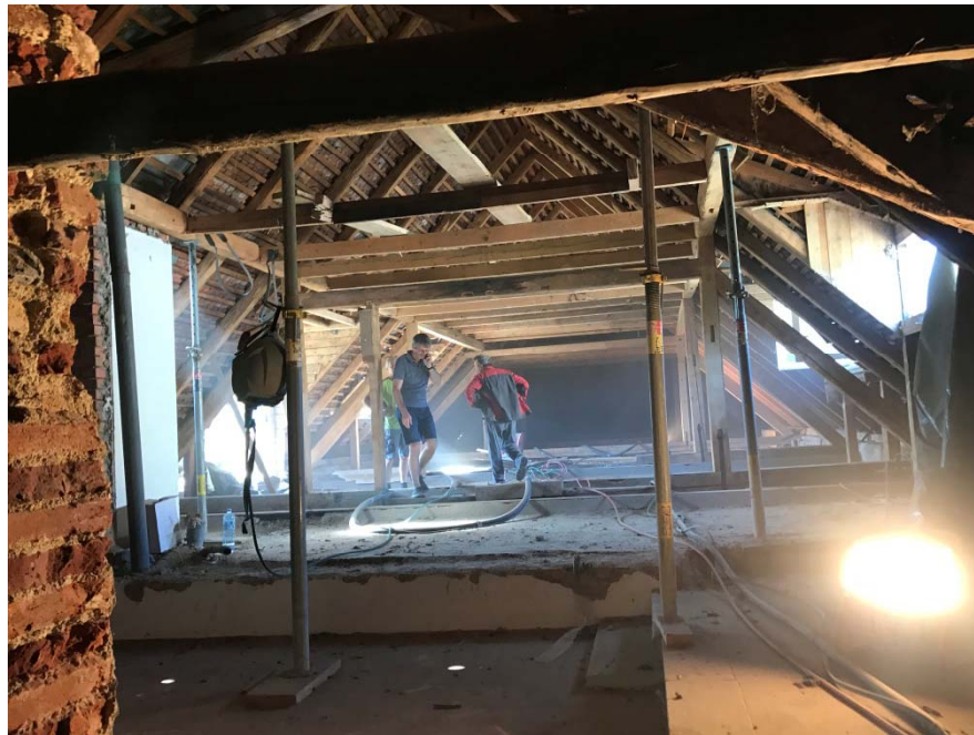
NACH DEM SANDSTRAHLEN DER TRÄGER
